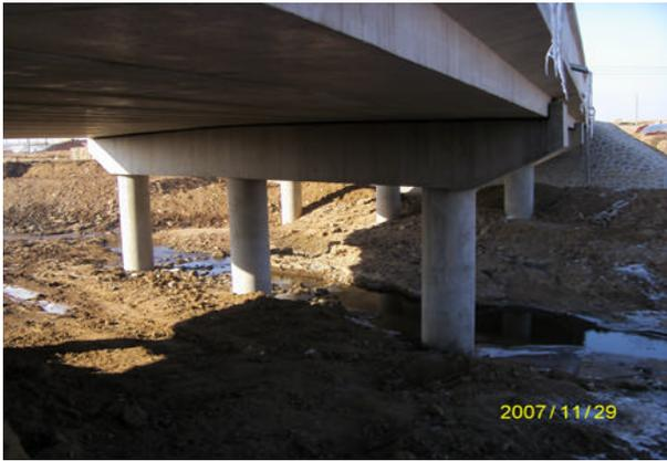
图 5.5 桃陨线桥盖梁及柱
