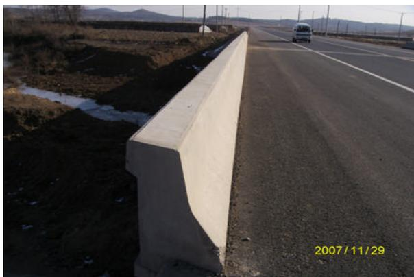
图 5.3 桃陨线桥梁防撞墙图
