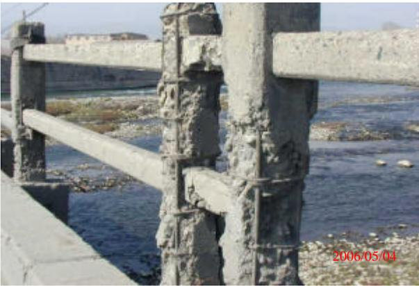
图 2.11 改造前的苏赵线桥面护栏
